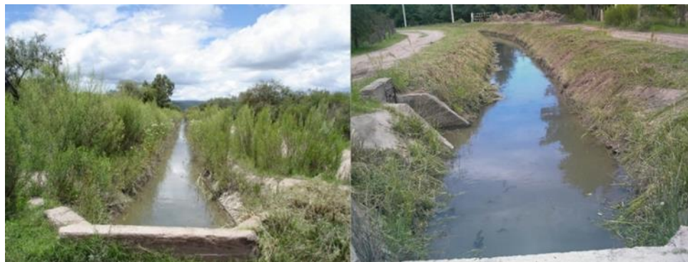
Figura 8. Tramo de canal antes y después de control de maleza con equipo ligero en el Distrito de Riego 025 Río Bravo, Tamaulipas.
