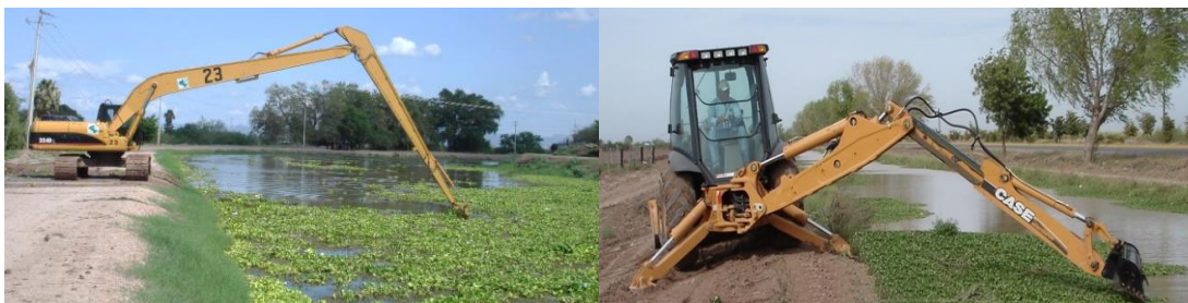
Figura 5. Extracción de lirio con excavadora hidráulica en el Distrito de Riego 041 Río Yaqui, Sonora y retroexcavadora cargadora en el Distrito de Riego 075 Río Fuerte, Sinaloa.
