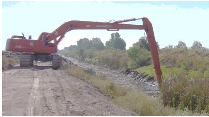
Figura 6. Extracción de tule con excavadora hidráulica en el Distrito de Riego 005, Ciudad Delicias, Chihuahua.
